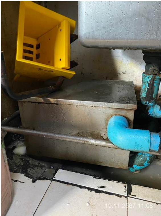
ภาพที่ 30 แสดงถังดักไขมันเบื้องต้นภายในห้องครัว และก่อนลงบ่อดักไขมัน
