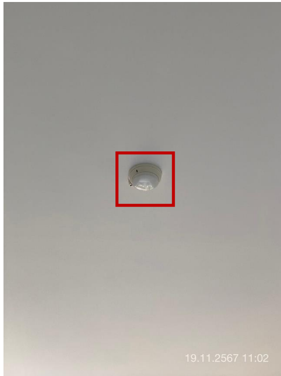
ภาพที่ 7 แสดง Heat Detector ภายในห้องพักแขก
