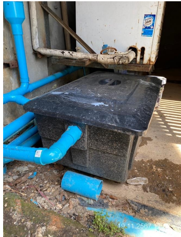
ภาพที่ 30 แสดงถังดักไขมันเบื้องต้นภายในห้องครัว และก่อนลงบ่อดักไขมัน
