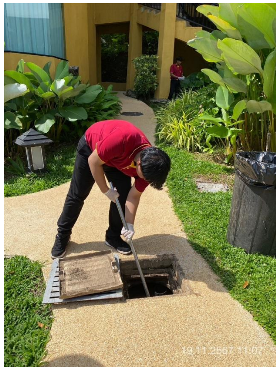
ภาพที่ 4 แสดงการตัดไข่มัน / บ่อตัดไข่มัน
